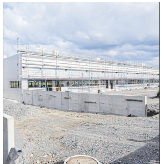
Endspur am neuen Verteilzentrum der Post DHL Group auf dem „Perfekten Standort“ beim Kleinglattbacher Kreisverkehr. „Laut Bauplanung soll der Zustellstützpunkt in Vaihingen Mitte Juli fertiggestellt werden“, lasst die Pressestelle in Stuttgart auf Anfrage wissen. „Ein konkretes Datum für den Umzug und die Inbetriebnahme ist zum jetzigen Zeitpunkt noch nicht fix.“ Betreut werden von hier aus Vaihingen, Enzweihingen, Pulverdingen, Riet, Hochdorf, Eberdingen, Nussdorf, Aurich, Roßwag, Kleinglattbach, Ensingen, Horrheim, Gündelbach und Oberriexingen. Der Stützpunkt an der Ecke Hans-Krieg-Str./Frankstraße in Vaihingen wird aufgegeben. Dort ist die Post Mieter. Foto: Aming
